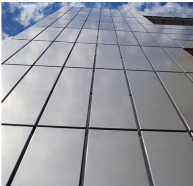
Облицовочный материал из сплава титана, цинка и меди Производство: Московская область
